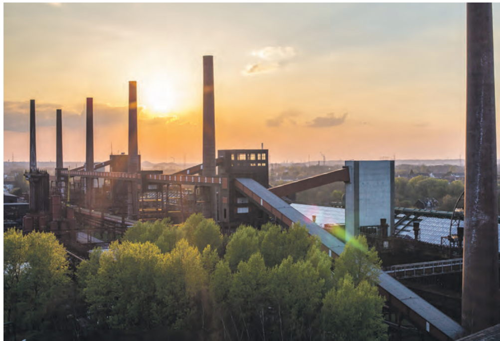
Das Mauerwerk der sechs denkmalgeschützten Türme war instabil, sie mussten aufwändig saniert werden, um sie vor dem endgültigen Verfall zu bewahren. (Fotos: Jochen Tack/Sebastian Scholz)
