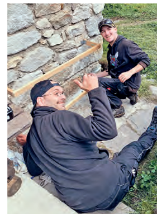
An der Hütte musste einiges ausgebessert werden.
