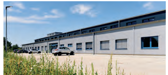
Neubau (Gebäude 13) auf dem Gelände der Triple Z AG.
