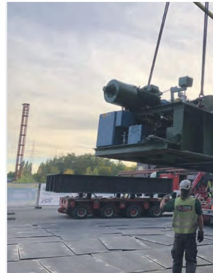
Mit einem schweren Mobilkran wurde ein Bauteil abgenommen und in Position gebracht. Die neue Seilfahrtsanlage eingesetzt.
