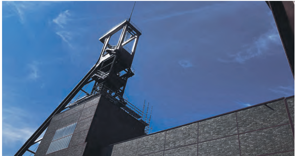
Die Sanierungsarbeiten am Fördergerüst von Schacht 1/2/8 sind abgeschlossen. (Foto: Hanna Lohmann)
