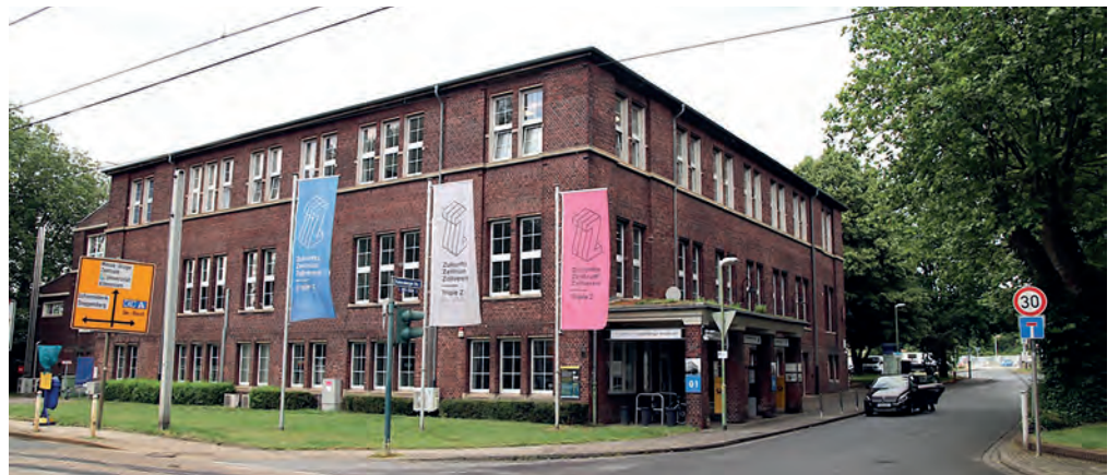
Die Einfahrt des Zukunftszentrum Zollverein mit „Gebäude 1“ heute.
