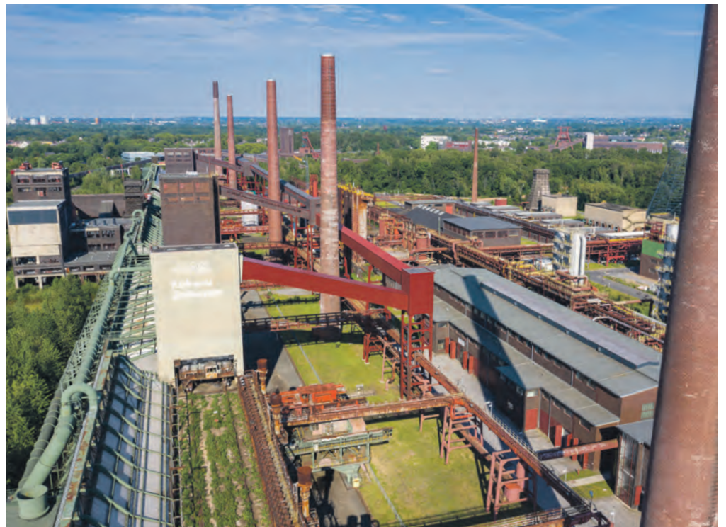
Der Blick über die Koksofenbatterie, ganz hinten die Mischanlage. Das Gebäude hinter dem hellen Turm mit dem RAG-Schriftzug ist der Kohlenturm 1, ihm rechts gegenüber die Vorkühler. (Foto: Jochen Tack)
