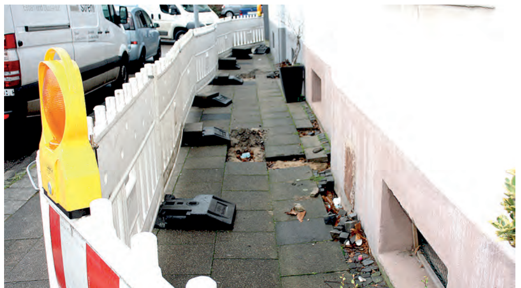
Der Bereich vor dem Haus wird durch Absperrungen gesichert. Die Löcher wurden provisorisch abgedeckt. (Foto: greis)
