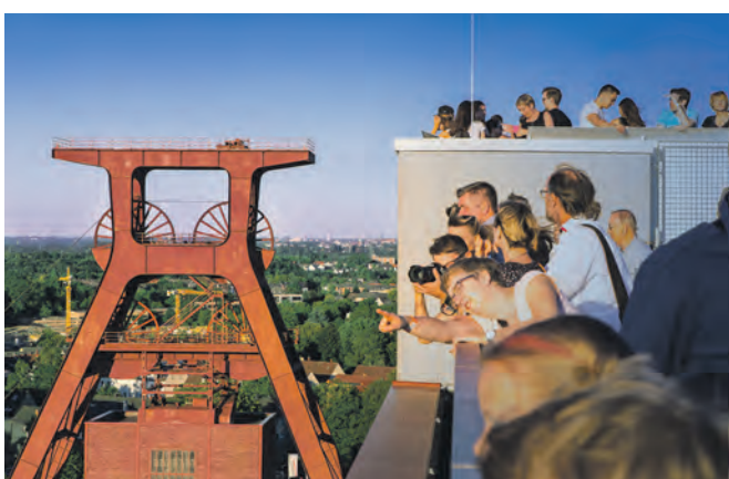
Das Dach der Kohlenwäsche bietet einen fantastischen Panoramablick über Zollverein und das Ruhrgebiet. (Foto: Jochen Tack)
