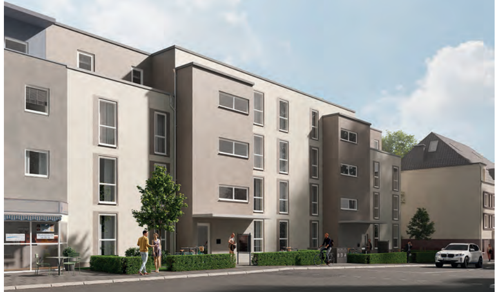
In Schonnebeck entstehen zwei viergeschossige und unterkellerte Mehrfamilienhäuser. (Fotos: Allbau)
